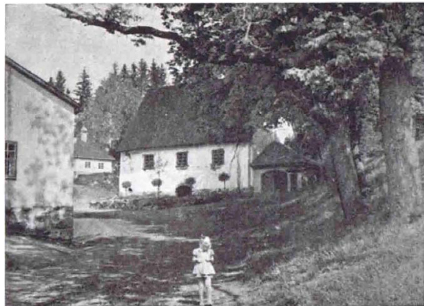
33. Gårdsbyggnader på Sjundby.
