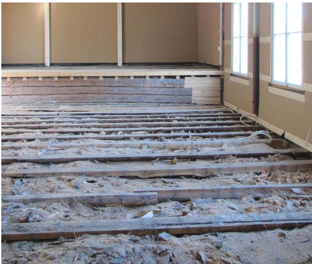
13.5.2012. De olika skedena har avlöst varandra i rask takt under våren. Här har golvbräderna rivits och förts bort. De översta balkarna och golvfyllningen är ännu kvar.
