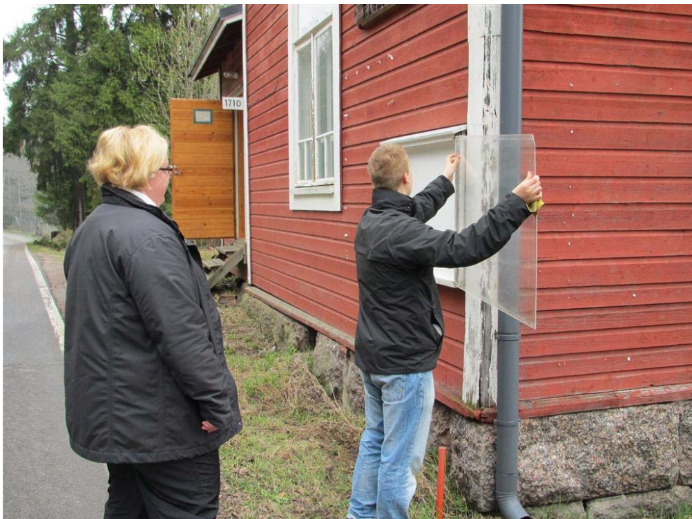
Magdalena Pitkänen tittar på när sonen Alexander monterar upp anslagstavlan på Rigårdsnäs yttervägg. Alexander gjorde ett snyggt arbete och reparerade den skadade anslagstavlan, som hade fallit ner under vintern.
