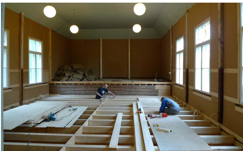
2.6.2012. Nu är alla de nya golvbalkarna på plats och trossbottnet är under arbete.
