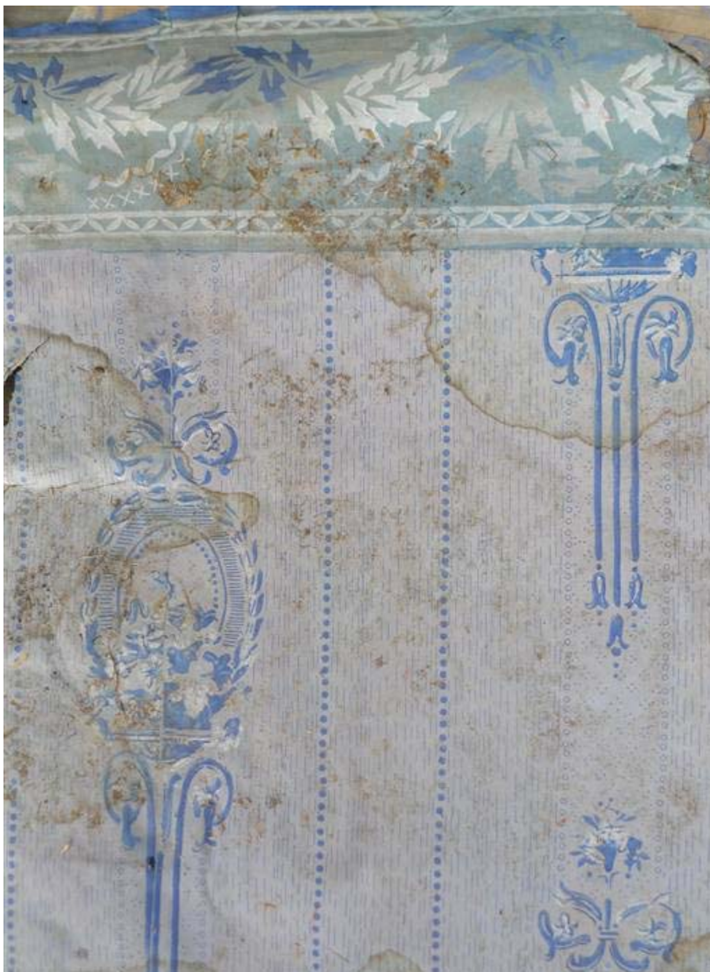
Litet fuktskador ses på en här tapeten, som hittats på alla väggarna i festsalen. Frågan är nu, är den här tapeten av ryskt eller finskt ursprung?
