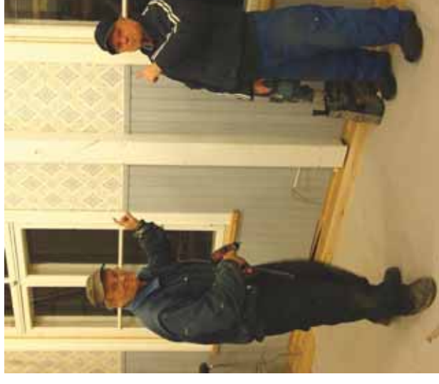
Erik och Elmer Eklund pekar på "följarna" som stöder upp stockväggarna. Under vintern har bröderna monterat nya täckbräder på följlarna. Nedan är de i farten med att förnya danslavsens räcken.
