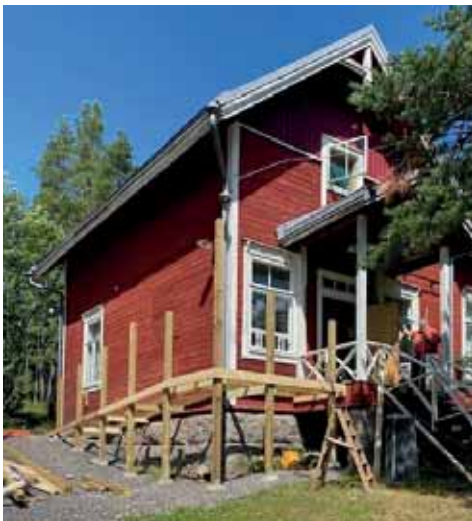
Stommen på rampen börjar vara på plats. Rampens stolpar fortsätter uppåt och bildar samtidigt stabila stolpar för räcket.
