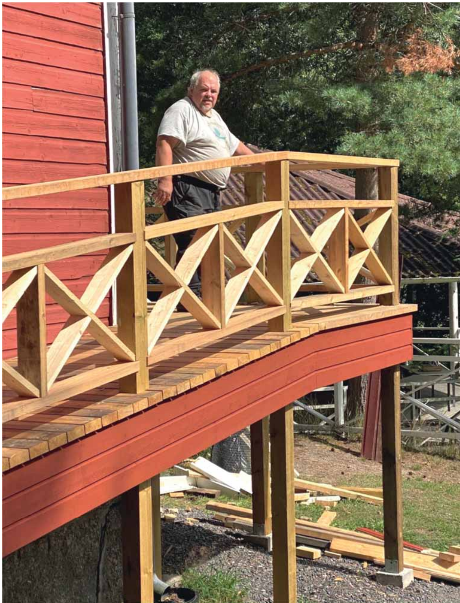
Jyrki Tolvanen gör som intendent mycket osynligt arbete för föreningen, men rampen och räcket blev i stället i högsta grad synligt. Här kan ni beundra både honom och det snygga snickeriarbetet på rampens räcke. Okej, vi andra hjälpte nog till också... (23.7.2020)
