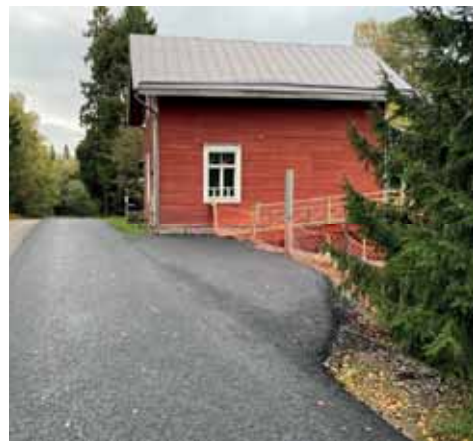
I samband med asfalteringen av Porkalavägen fick vi asfalt på den nya invaparkeringsplatsen.
